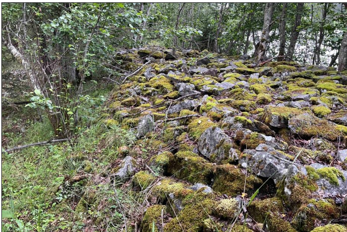
Figur 10. Sørøst for der kanalen kommer ut i elva er det bygga opp en stor voll. Vollen har rettet ut elveløpet og hindret flompåvirkning på områdene innenfor. I dag er det en åpning i muren som gjør at noe vann likevel slipper igjennom. Foto: Sara Margrete Gilberg Nyjordet.
