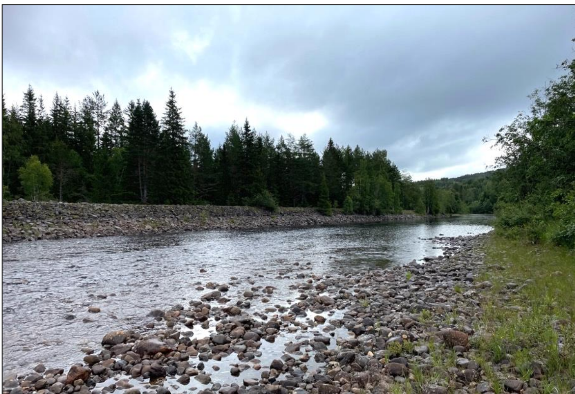
Figur 5. Det ble bygget flomsikring langs nordsiden av Numedalslågen øst for utløpet av Tundra i 1942 som har redusert flompåvirkningen på skogen bakfor den utfylte vollen. Foto: Kamilla Svingen
