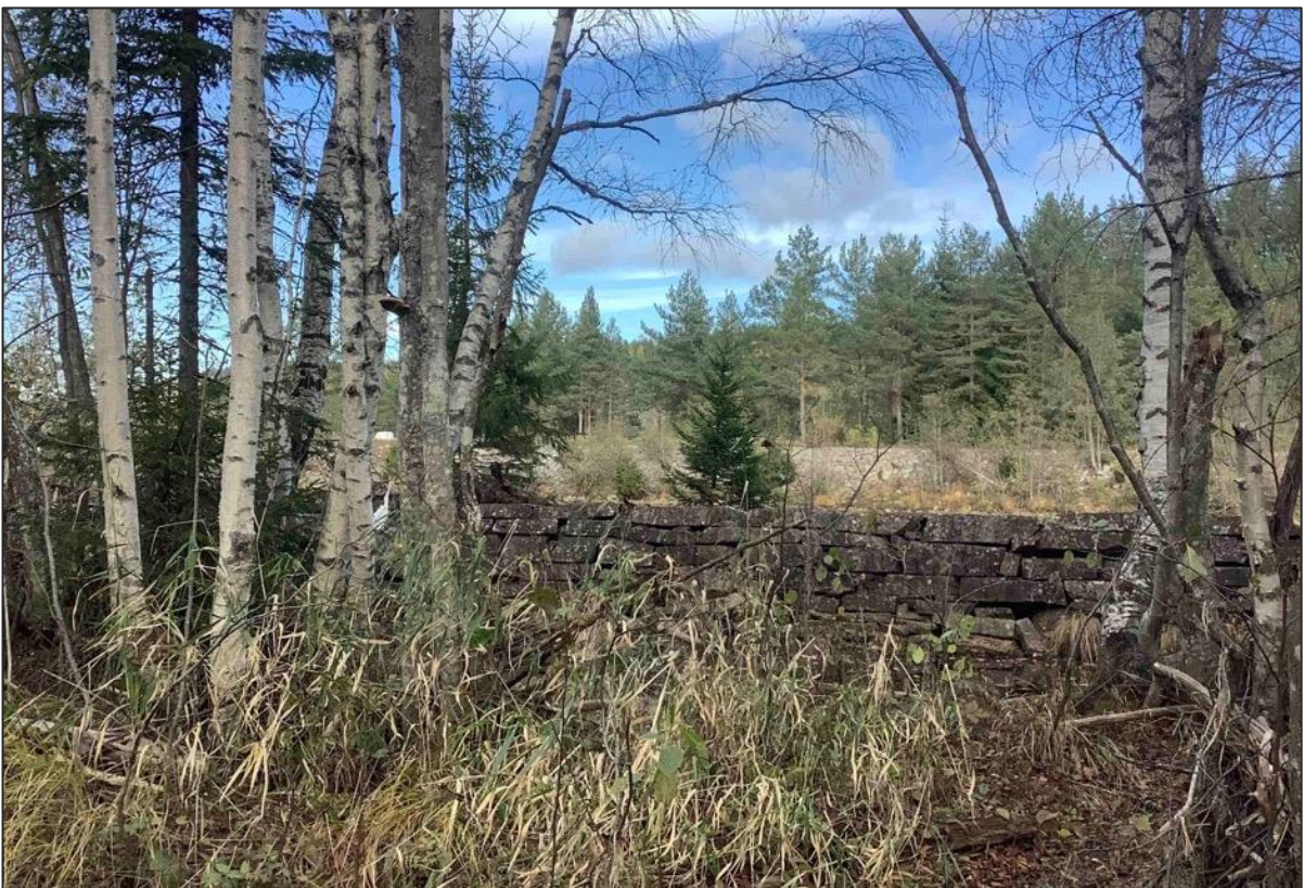
Figur 23. Mellom Hellengje og Bjørkengje er det lagt opp en steinmur for å sperre av et eldre flomløp. Foto: Kamilla Svingen
