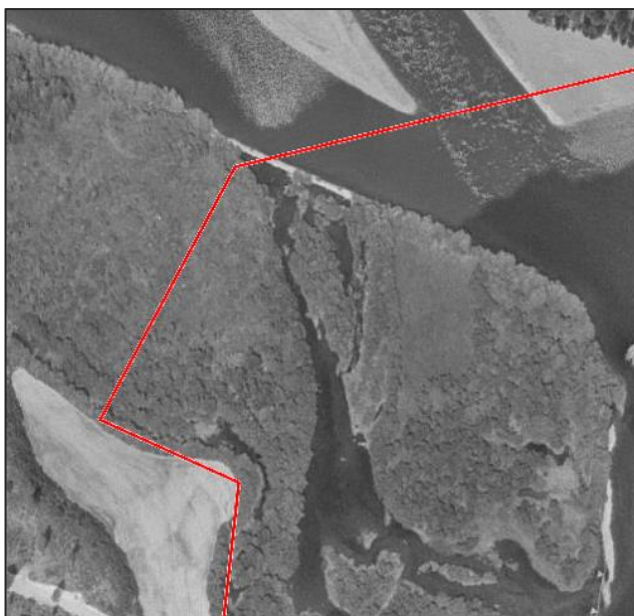
Figur 21. Mellom Bjørkengje og Hellingje er det lagt opp en steinmur som reduserer flompåvirkningen gjennom dette flomløpet. Muren er synlig i nordvestlig hjørne av prosjektområdet på flyfoto fra 1978.
