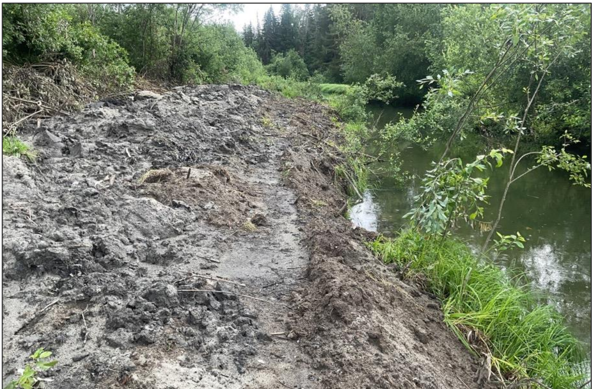
Figur 66. Kanalen der Hvamselva renner ut i Øyenlågen ble mudret i 2023. Massene er lagt på siden, som en slags flomvoll. Foto: Kirstin Maria Flynn Steinsvåg.
