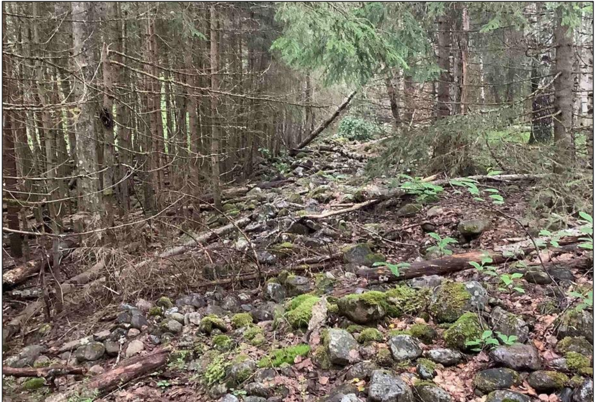
Figur 7. Bildet viser flomforbygningen som er bygd på Oreholmen lang sørsiden av elveløpet. Bildet viser et parti hvor forbygningen delvis har rast sammen. Foto: Kamilla Svingen
