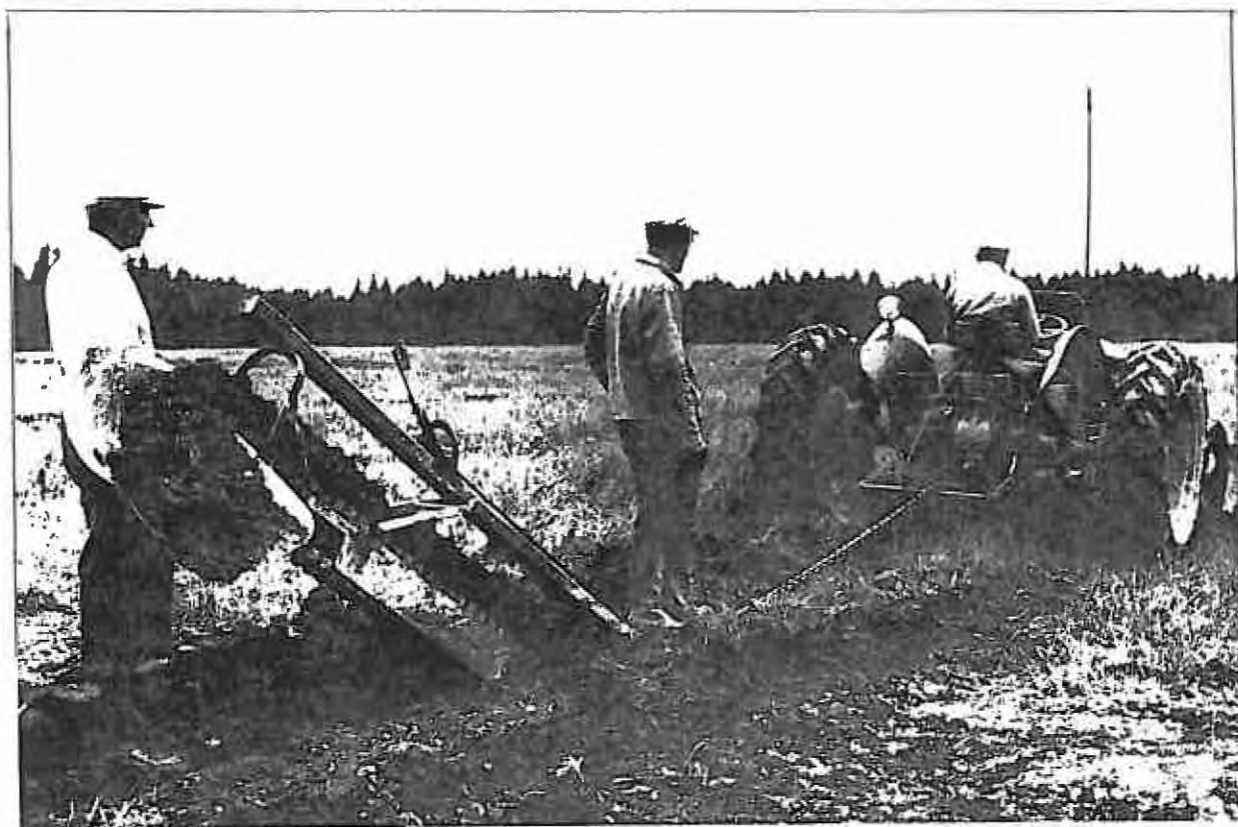
Fig. 9. Grøfthing med grøfteplog på Kirkeby, Trøgstad (1950). ( Østfold Fylkes Billedarkiv).
