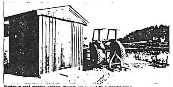
Stanken er også merkbart utendørs allersom den spres ut fra pumpestasjonen
