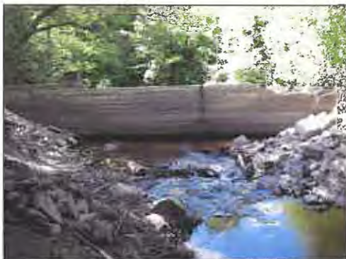
Fig. 5. Demningen ved Vegger (vannsidan).
