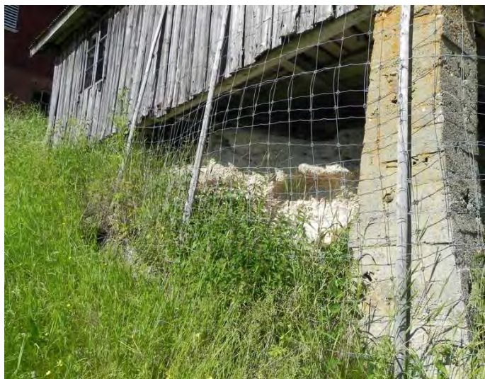
Figur 11. Under den gamle låven ser en rester etter den gamle skjellsandutgravningen. Dette er den fineste resten etter skjellmergel i kommunen. Foto 2012. (UTM32: Ø645326, N6579482).
