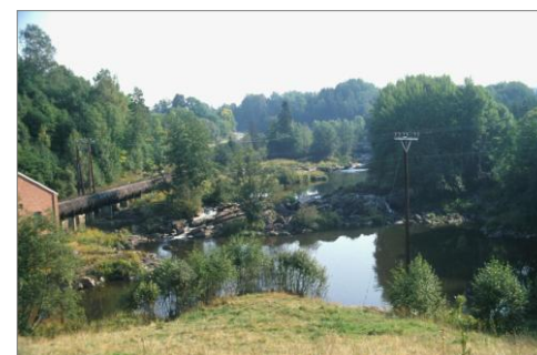
Buerfossen med rørgata, sett oppover, 1990
