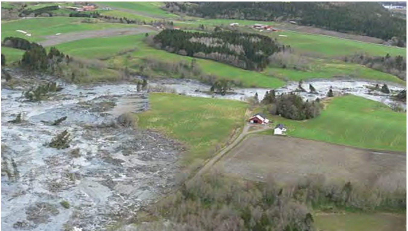
Skredet i Overhalla, 2007, FOTO: Adresseavisen/ 330 Skvadronen
