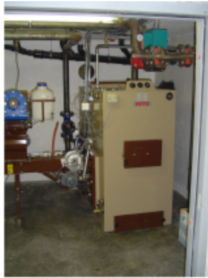
Anlegg i eksisterende bygg
