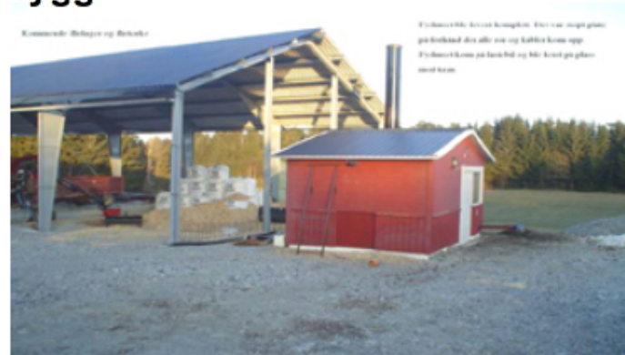
Anlegg i frittstående bygg
