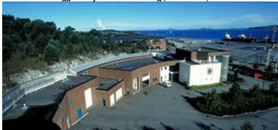
Sentralreinsanlegg i Mekjarvik i Randaberg (IVAR 2008)
