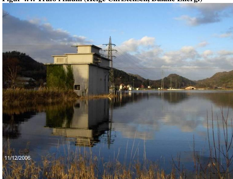
Figur 4.4: Trafo i flaum (Helge Christensen, Dalane Energi)
