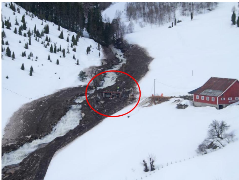
Figur 3.11: Restar av hus tatt av sørpeskred i Balestrand mars 2011, der to omkom (NGI 2011)
