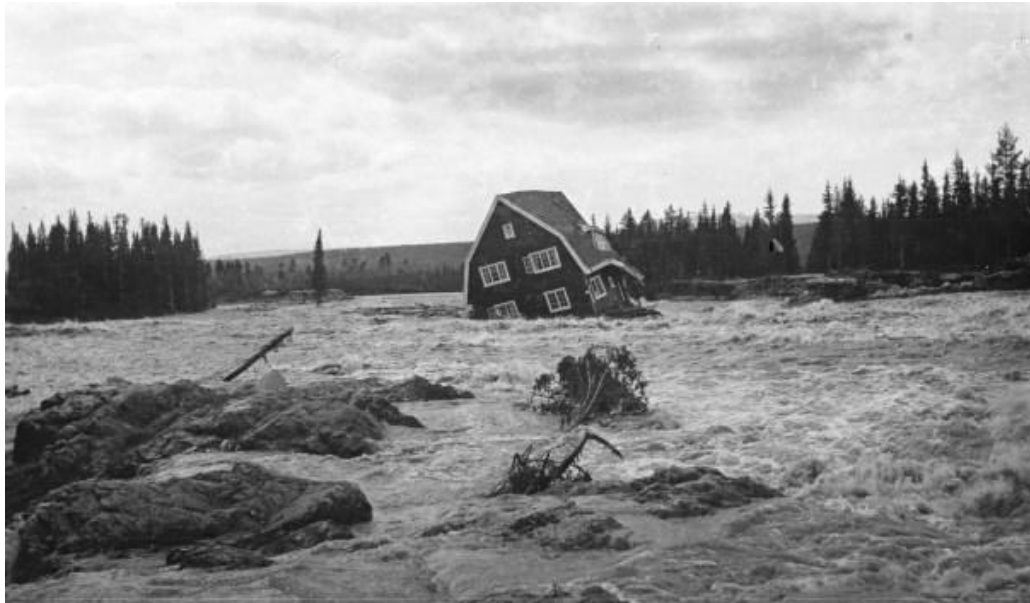
Figur 8.22: Maskinistbustaden etter dambrot ved Osfallet 10. mai 1916 (NVEs fotoarkiv)
