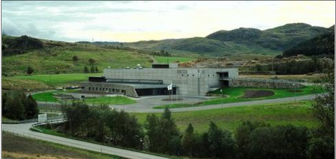
Figur 4.8 Langevatn vassbehandlingsanlegg (IVAR 2008)
