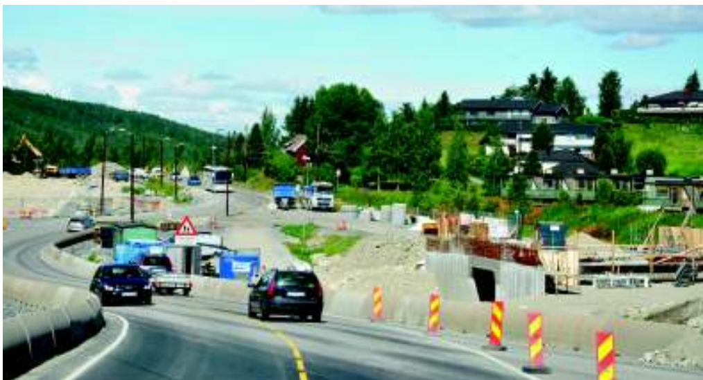
Vegbygging. Foto: Marianne Gjorv
