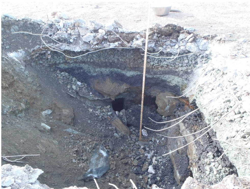
Figur 15: Sjakt 12, under armert betongdekke. Ingen løsmasser under 100 cm.
