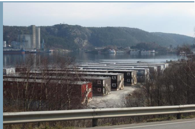
Figur 9: Brakkerigg i Holeviga på nedsprenget arealer
