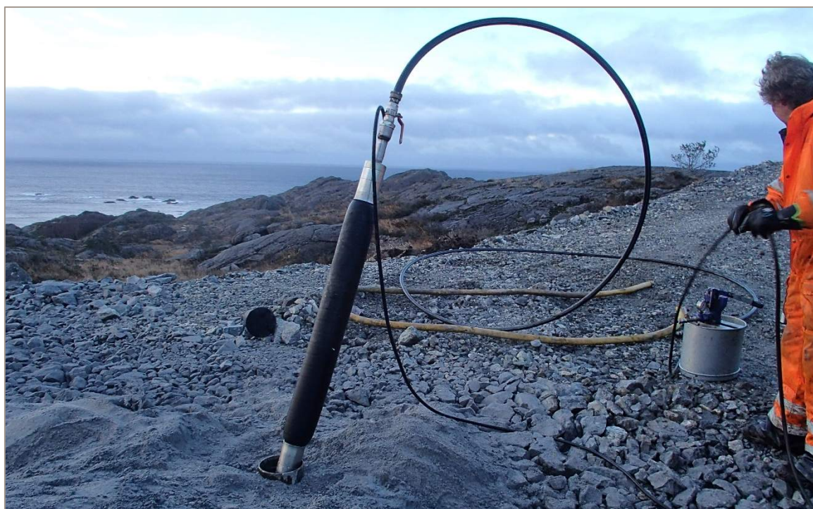
Figur 5 Hydraulisk testing av brønnene (Foto: Arve Misund).
