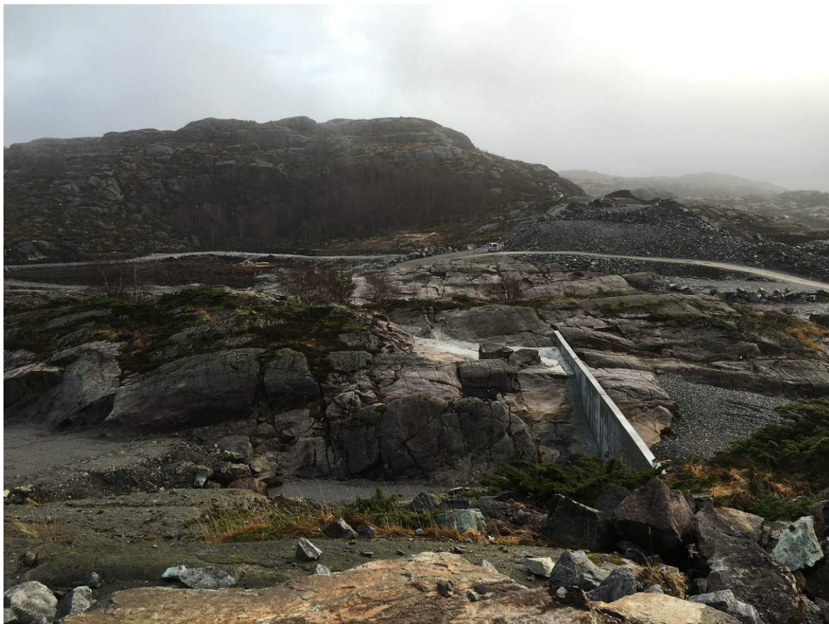
Figur 6 Den østre demningen er etablert og vil være en ekstra sikkerhet mot lekkasje i de mest markante sprekkesonene (Foto: Arild Vatland).
