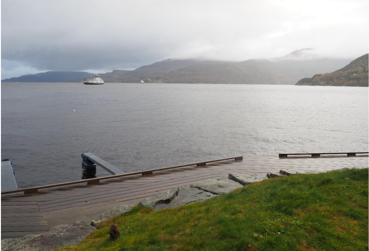
Figur 5. Trebrygge øst for dagens ferjekaipir rives som følge av utfyllingen.
