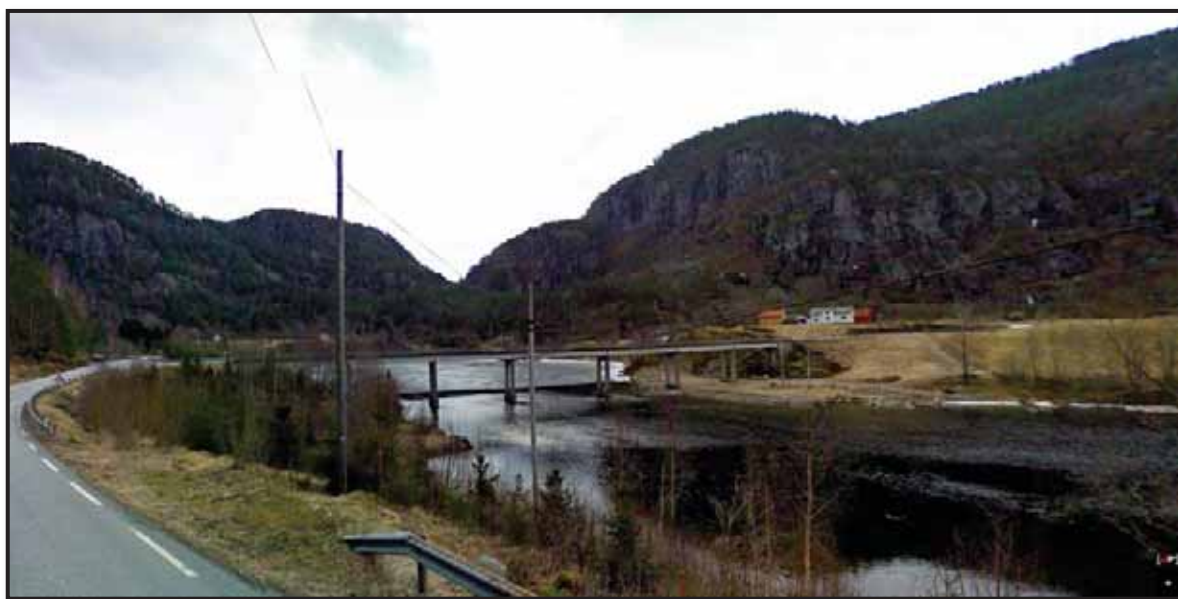
Figur 9 Helganes bru, bilde fra Google street view.
