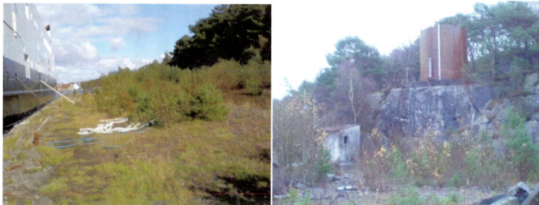
Figur 3: Venstre: Kulltomta – mot øst. Høyre: Drivstofftank og transformatorhus
