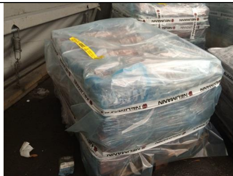
Pakka asbest på palle
