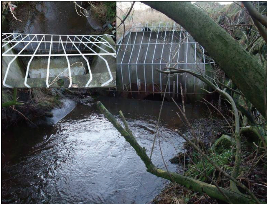
Figur 2.11: Bilde av terskel frå Harvalandsvatnet og overgang til Selekanalen. Nærbilde av terskel er limt inn øvst i bilete.
