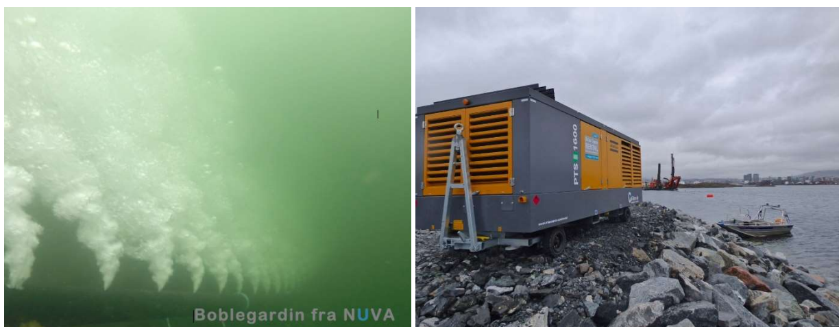
Figur 9: Boblegardin installert av NUVA i Indre Oslofjord. Til venstre: Luftdyser på havbunn. Til høyre: Kompressor som leverer luft. (Norsk Undervannsarbeid, 2016).
