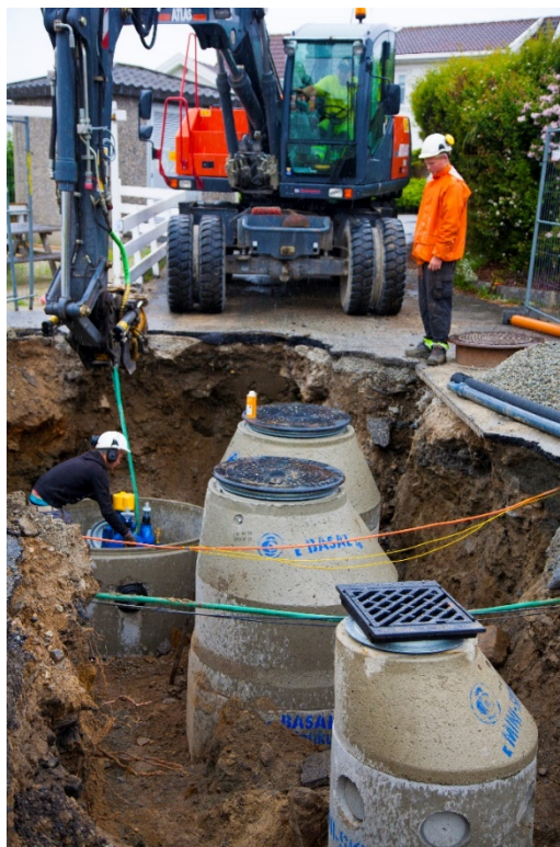
Bilde 17: Utbygging av vatn og avlaupsnett i Viste hageby (Foto: Ove Sveinung Tennfjord /Randaberg kommune)
