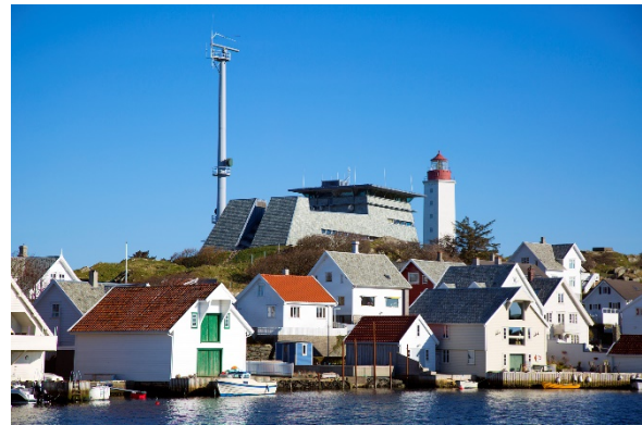
Bilde 52: Kvitsøy VTS (Foto: Ove Sveinung Tennfjord/Randaberg kommune)
