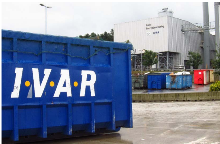
Figur 21: Forus Energigjenvinning (Foto: Ove Sveinung Tennfjord/Randaberg kommune)
