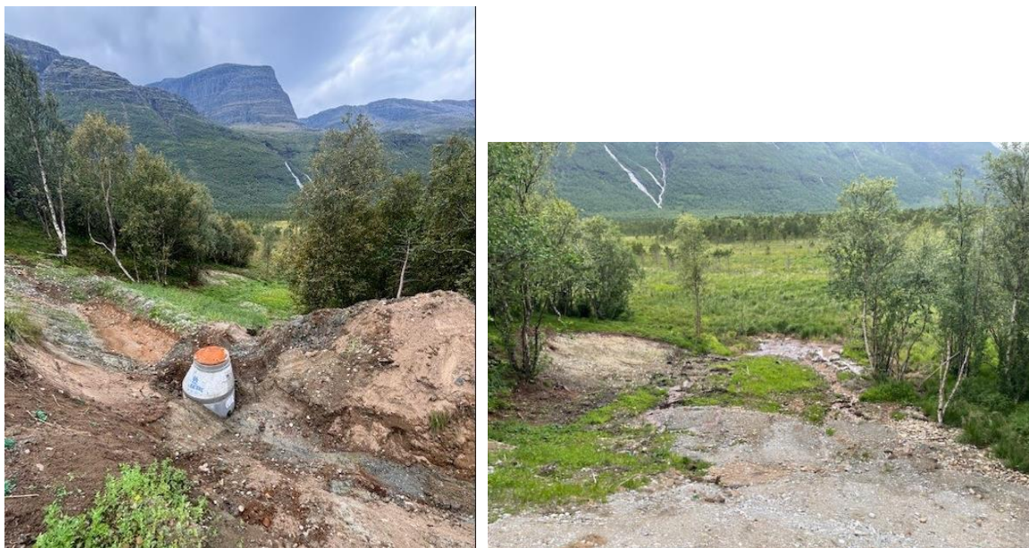
Figur 9 Tiltak 2024: Ny sigevann kum nedstrøm for deponi samler opp vann i drensør under deponi er etablert. Vann - prøve pkt. 2 i kart figur 4.
