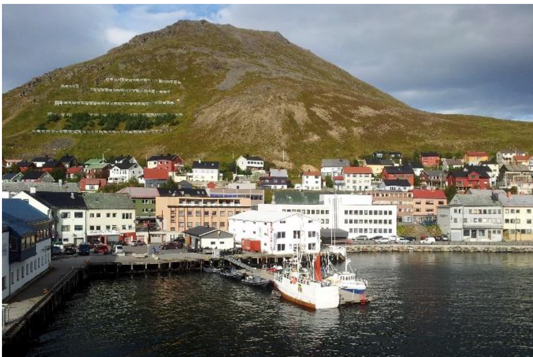
Bilde fra Honningsvåg med skredsikring ovenfor bebyggelse. Foto: Vigdis Johnsen
