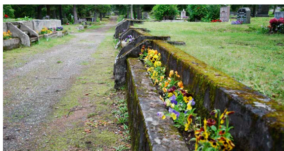
Teknikkhistorisk verdi, hevede gravfelt med betongkanter. Tromsø gravlund.
