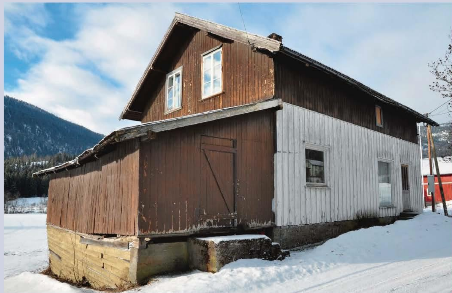
Holm Landhandel før renovering
