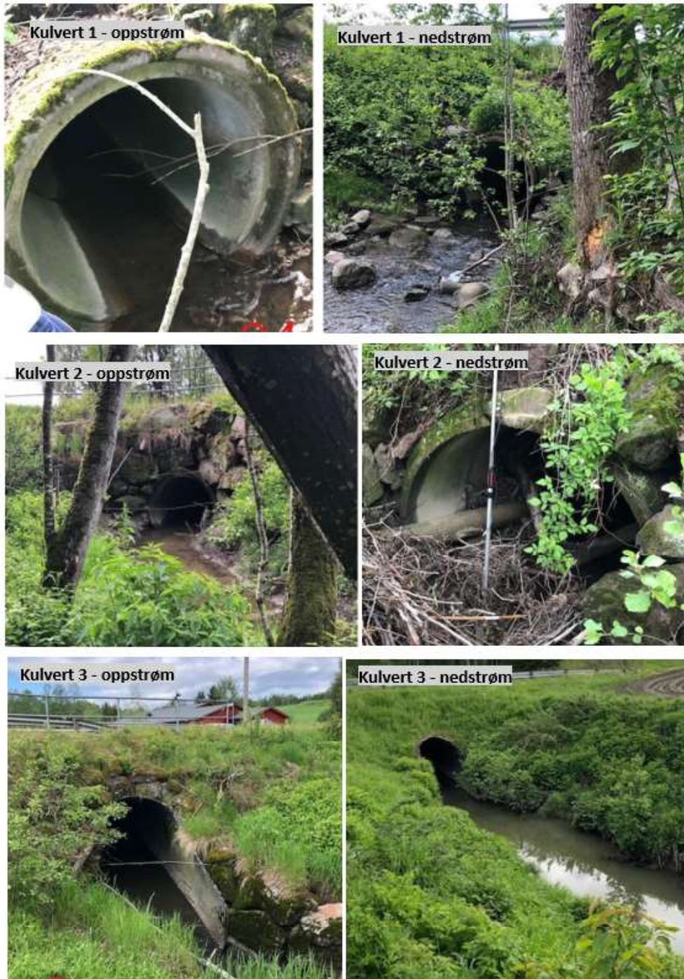
Figur 3-3: Bilder av kulvertene på aktuell strekning, Vesleelva og Vålebekken. Foto: Ingeniørservice AS.
