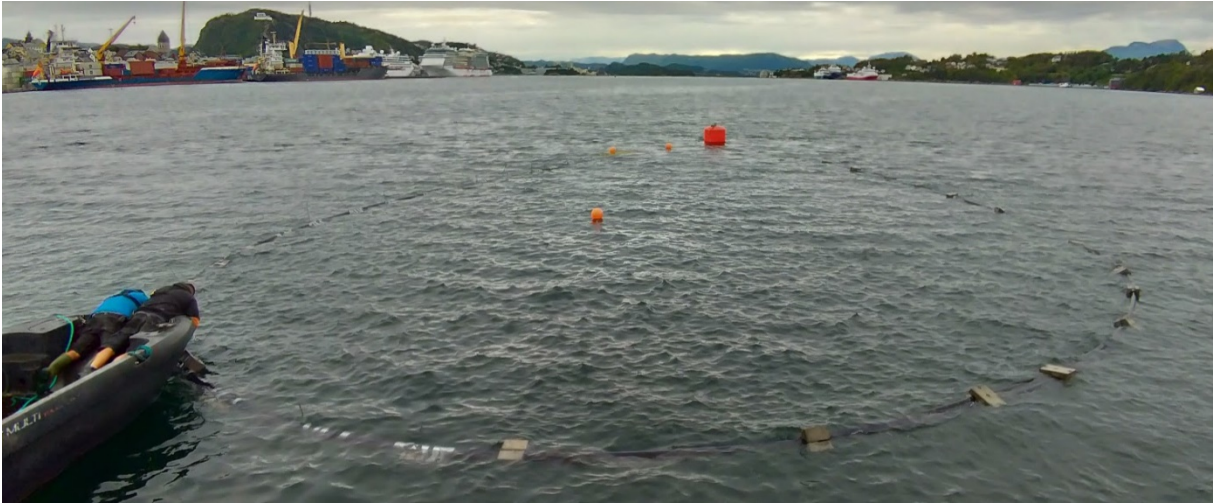
Figur 7 Montering av boblegardin i sirkulær konfigurasjon. Foto: Akvaplan-niva.
