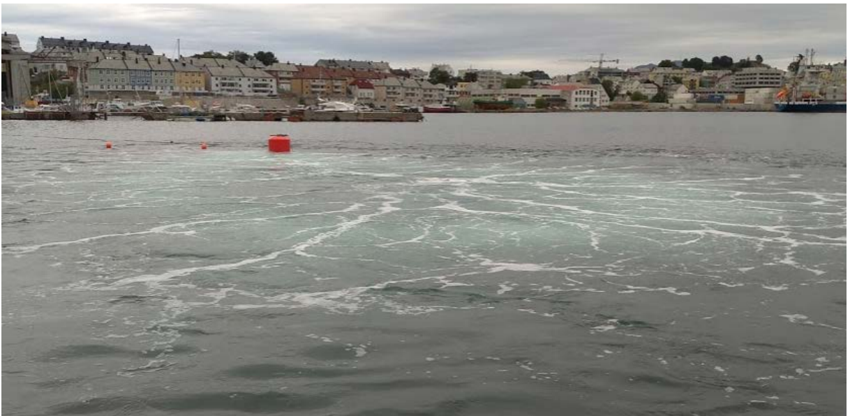
Figur 8 Boblegardin i drift i sirkulær konfigurasjon. Foto: Akvaplan-niva.
