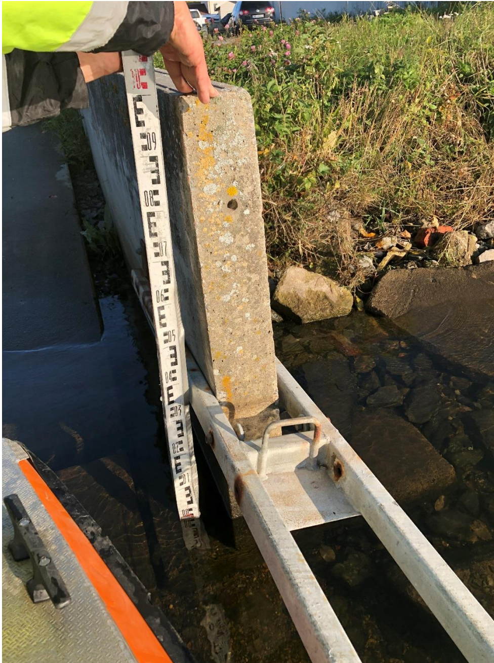
Figur 2: Ved tidspunkt for dybdemåling var vannstanden 1 m under topp av betongkonstruksjon på østre side av utkjøringsrampen innenfor undersøkelsesområdet.
