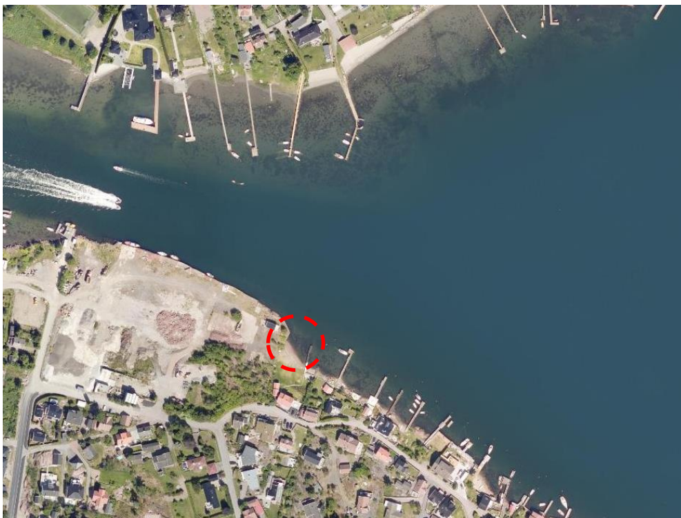
Figur 2: Flyfoto med dagens situasjon
