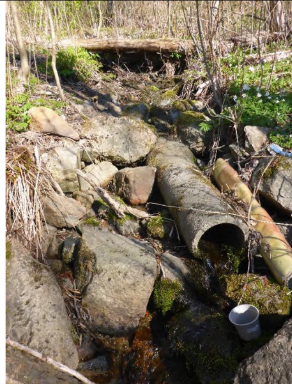
Bilde 6. 40 meter opp for munningen går det meste av bekken ut av en rørgate.
