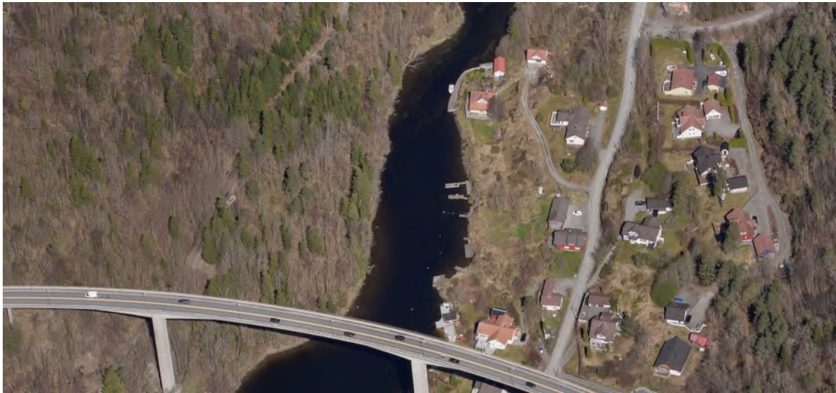
Figur 2.40. Langangssundet. Ny bru vil krysse over omtrent midt i bildet.
