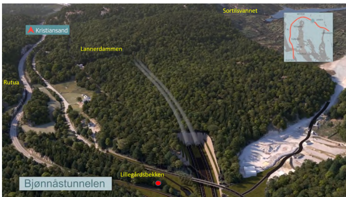
Figur 2.30. Viser stasjonen i Lillegårdsbekken, antatt påslag for Bjønnåstunnelen samt oversikt over Rutuas bekkeløp.
