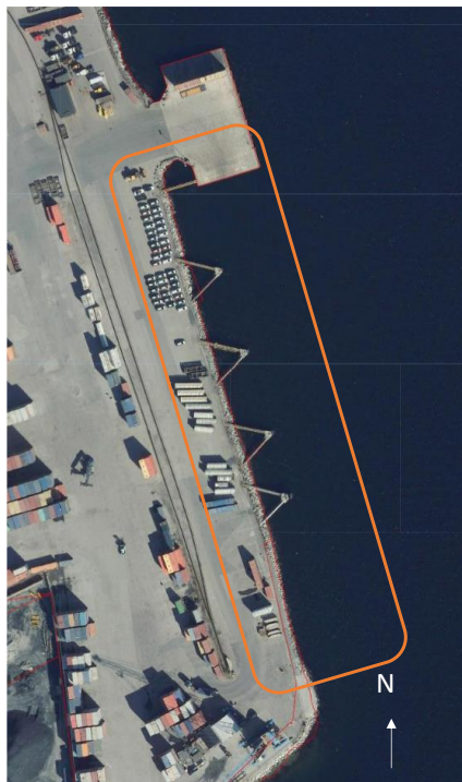
Figur 5-5 Eksisterende kai på Roro syd med fire dykdalber langs kaien og innkjøring fra nord. Anleggsområdet er vist med oransje omriss. Kilde: finn.no
