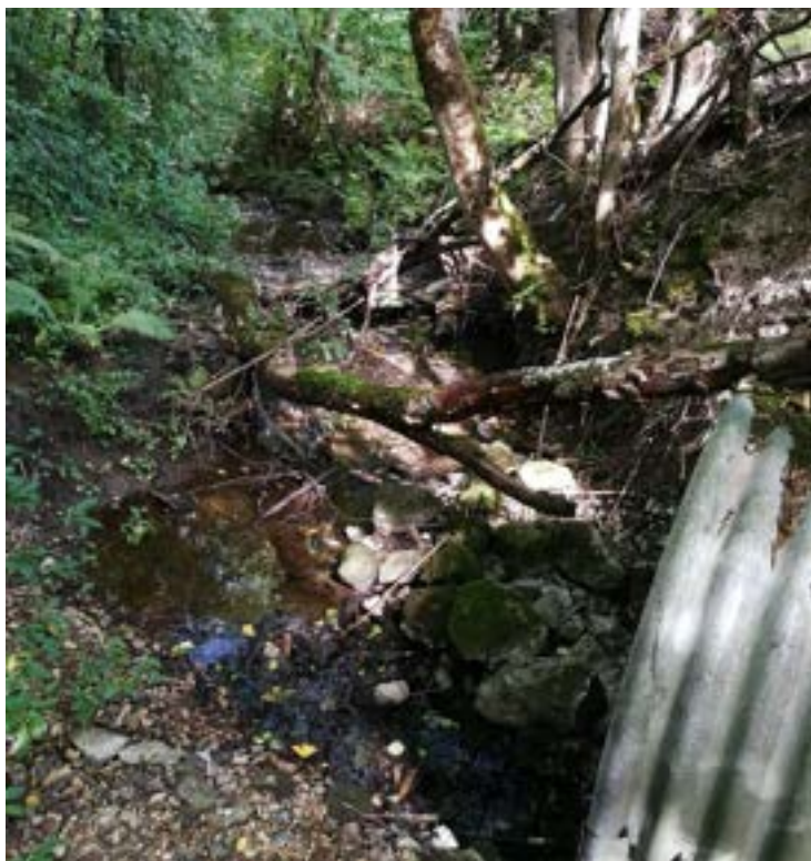
Figur 2. Oversiktsbilde fra stasjonen i Heistadbekken.
