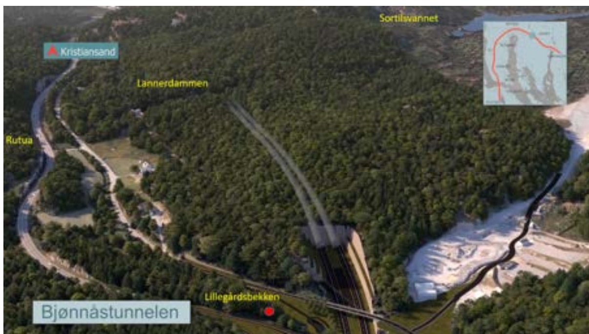
Figur 2.30. Viser stasjonen i Lillegårdsbekken, antatt påslag for Bjønnåstunnelen samt oversikt over Rutuas bekkeløp.
