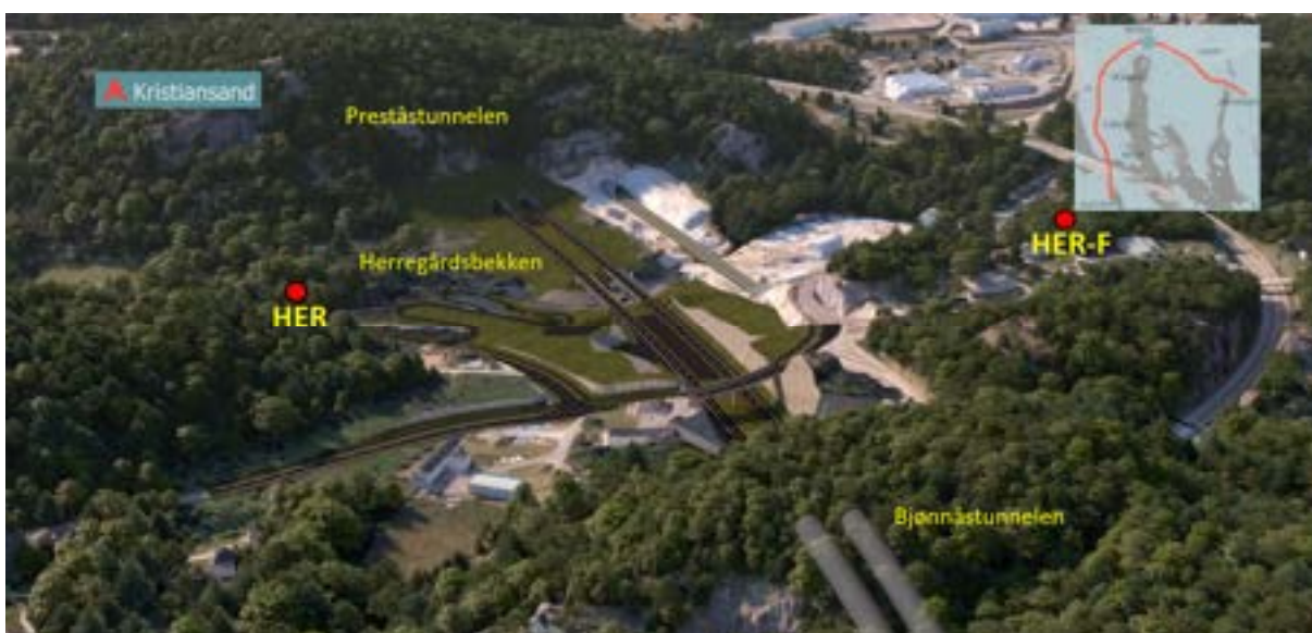
Figur 2.23. Dagsone for ny E18 over Herregårdsbekken, med Bjønnås- og Preståstunnelen
