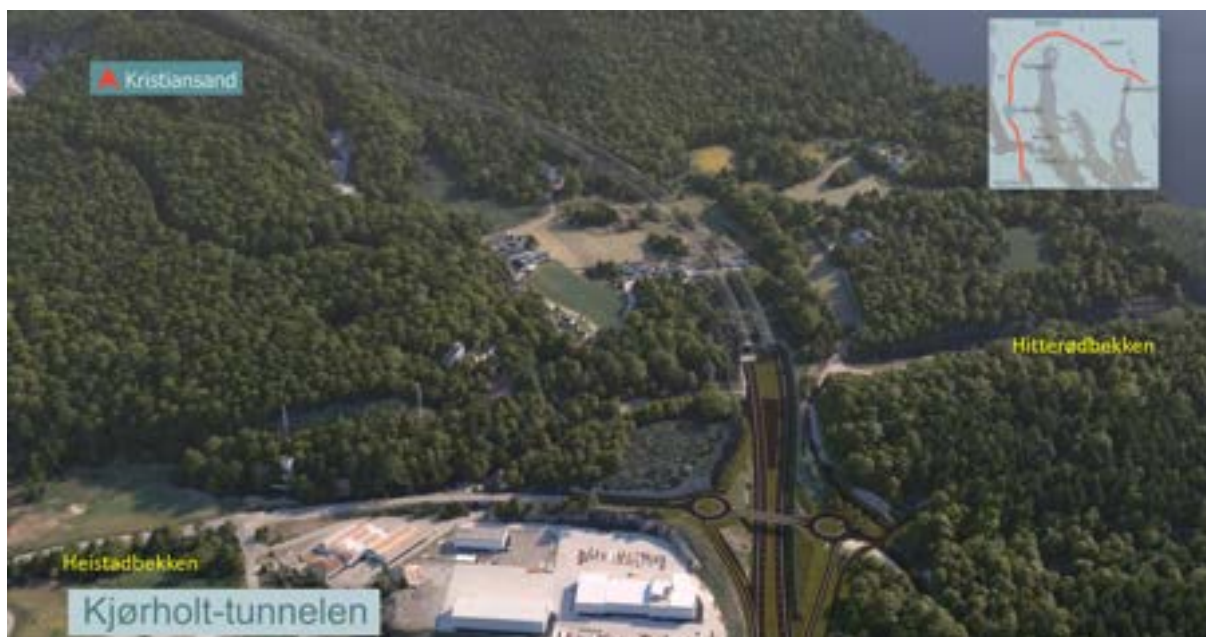
Figur 2.11. Illustrerer ny E18 i Heistadområdet før Kjørholt-tunnelen. I dette området er ny vei og Kjørholt-tunnel ferdigstilt.
