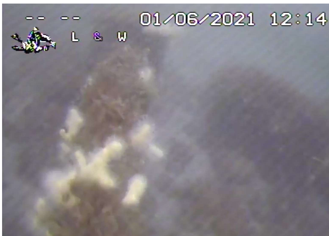
Ennå lenger ut har ledning meget god klaring til bunn, tidvis mellom 0,5 og en meter. Dette skyldes steinete bunnforhold.
