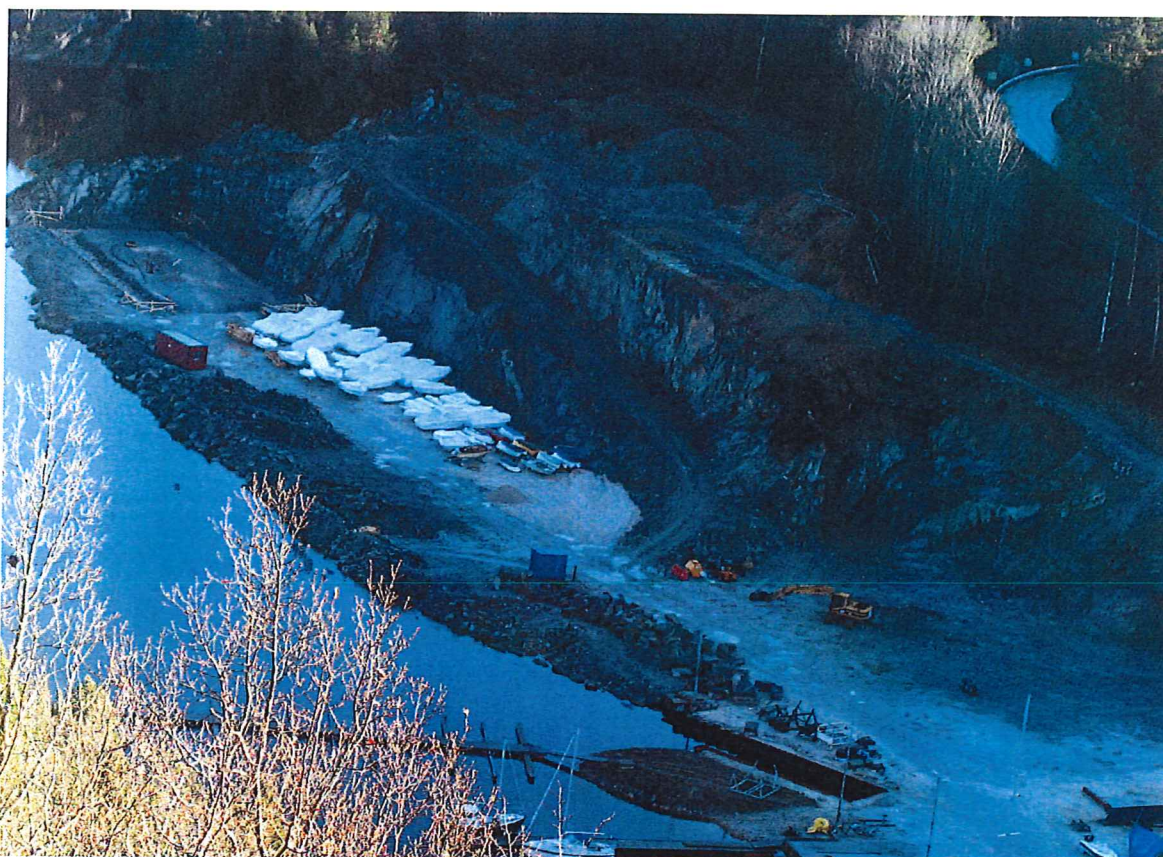
Figur 3: Sprenging, planering og utfylling i sjø på Sandtangen antagelig omkring 2005 (Kilde/foto: Terje Kiil).
