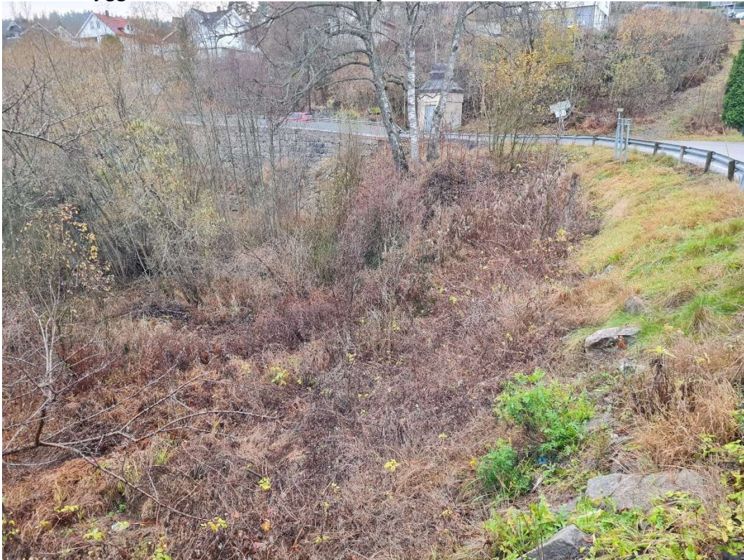
Fig. 2.2 Trase for motfylling/anleggsvei. Vegetasjon i område for adkomstvei. 3 bjørker lengst bak må fjernes i tillegg til noe busk/kratt ned til venstre for bjørkene..
