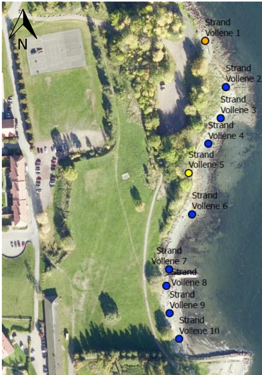
Figur 4.2: Flyfoto over stranden sør for «strand sør» der Forsvarsbygg tidligere har tatt prøver. Sirklene viser punkter der det er tatt prøver for kjemisk analyse. Fargene viser tilstandsklasser for bly. Figuren er et utsnitt av en tegning tilsendt av Forsvarsbygg.
