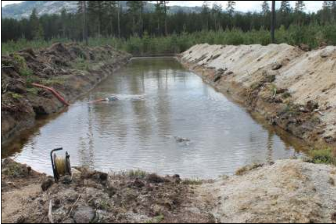
Figur 2: Infiltrasjonsforsøk på Langmoen. Vann fra elva pumpes til et åpent basseng på 8 x 50 m, og vannet infiltreres i stedlige løsmasser. Endringer i grunnvannsnivå registreres i peilerør.
