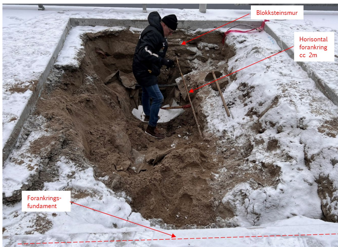
Figur 4. Bilde av prøvegropa på befaring den 08.12.2022.
