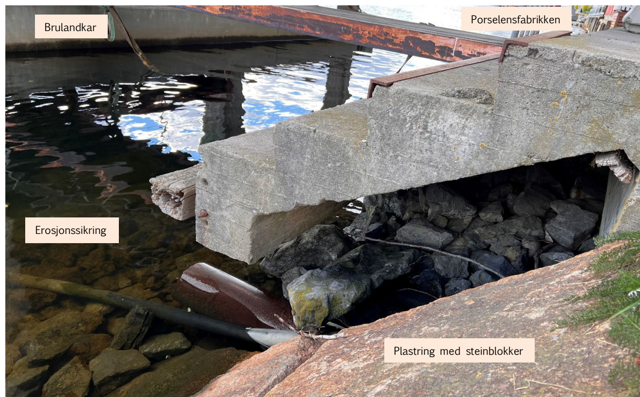
Figur 7. Bilde av elvekanten ved brulandkaret fra befaring den 13.09.2022.
