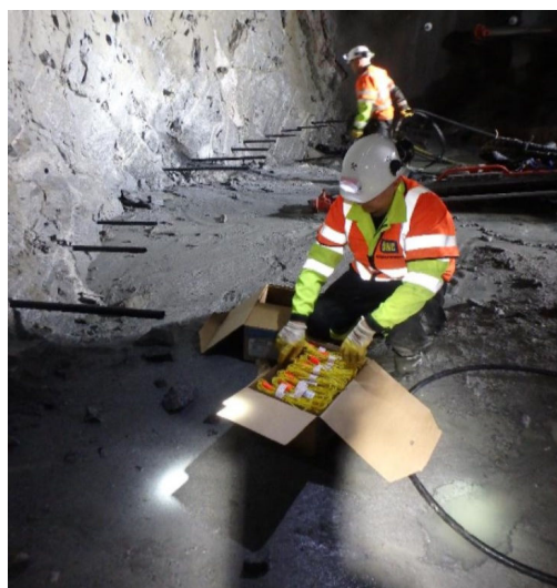
Foringsrør i borehull. Foto: Statens vegvesen
