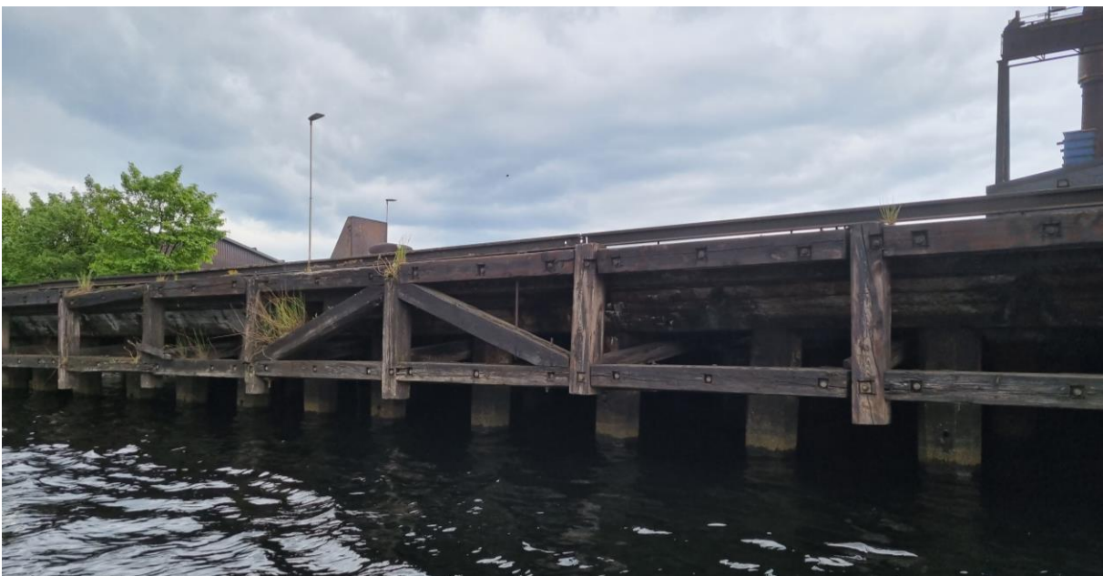
Figur 1-1: Bilde av eksisterende betongpelekai som skal rehabiliteres.
