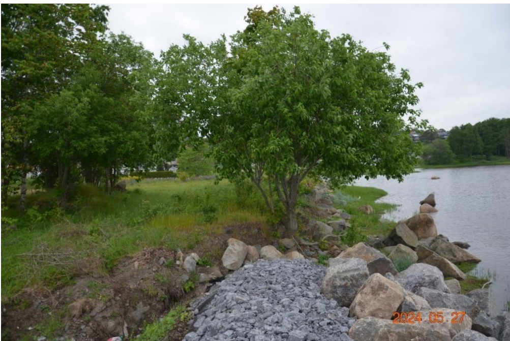
Figur 9 Avslutningen av erosjonssikringen som er utført i forbindelse med utbyggingen på gnr. 5001 bnr.495. Området bakenfor er det som nå skal sikres. Fotoet viser også treklyngene som ønskes bevart.
