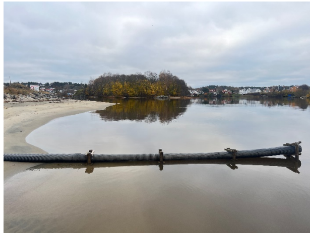
Figur 3: Kommunal overvannsledning som har utslipp ut i Lågen
