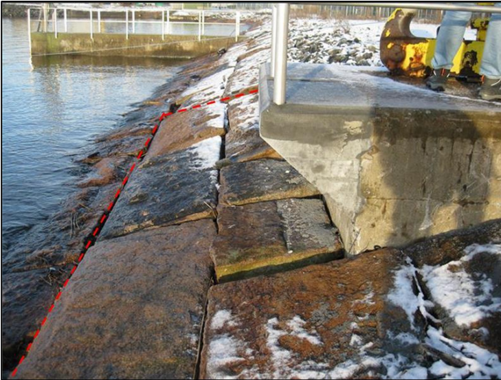
Figur 8: Eksisterende pullertfundament langs sjø hvor det skal etableres nytt fortøyningsfeste. Rød stiple linje viser estimert tiltaksområde.
