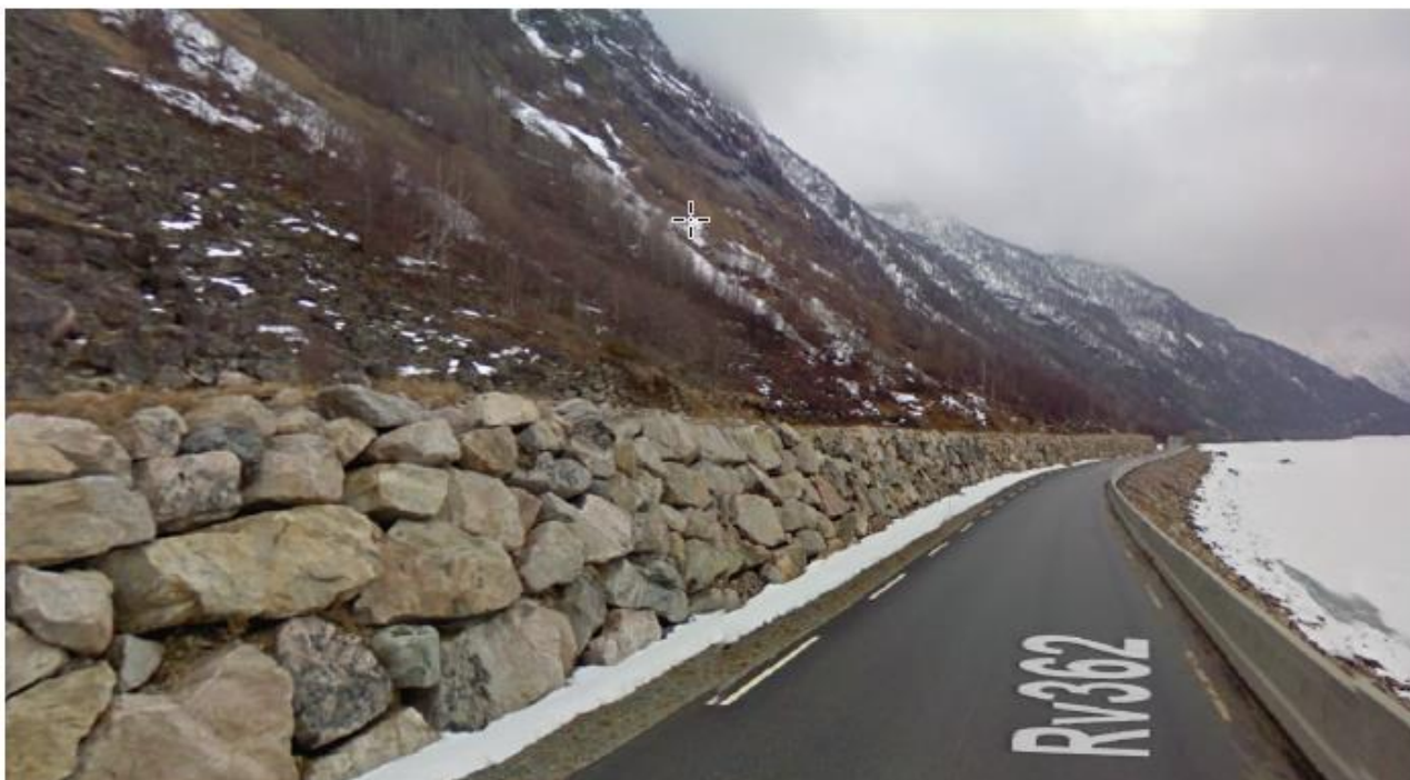
Figur 1-5. Eksempel på fangvoll kombinert med utlegging av veg. Sandviksskreda på fv. 362 i Vinje. Foto: Google street view 2010.
