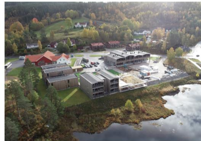
Alle foto: Iveland kommune
