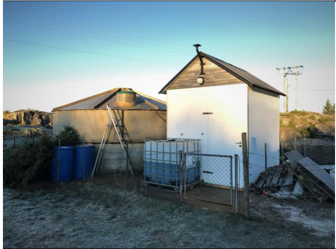
Figur 1. Noverande Ånneland private vassverk har for liten kapasitet og nytt anlegg vert planlagt.
