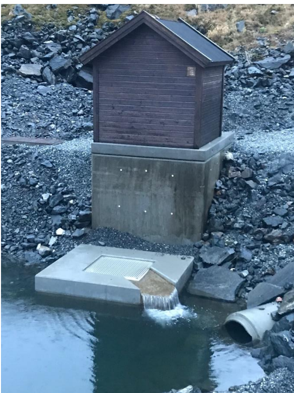
Figur 13. Utløp fra steinmagasin. Tak på huset tilsvarer omtrent topp av demning.
