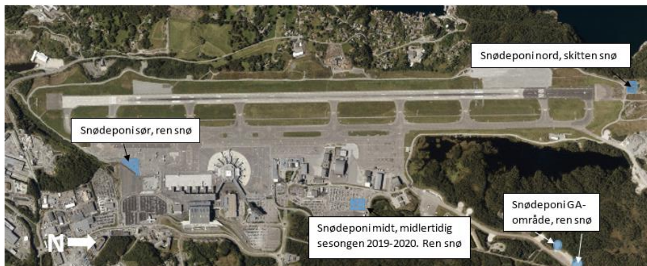
Figur 14. Plassering av snødeponier ved Bergen lufthavn.
