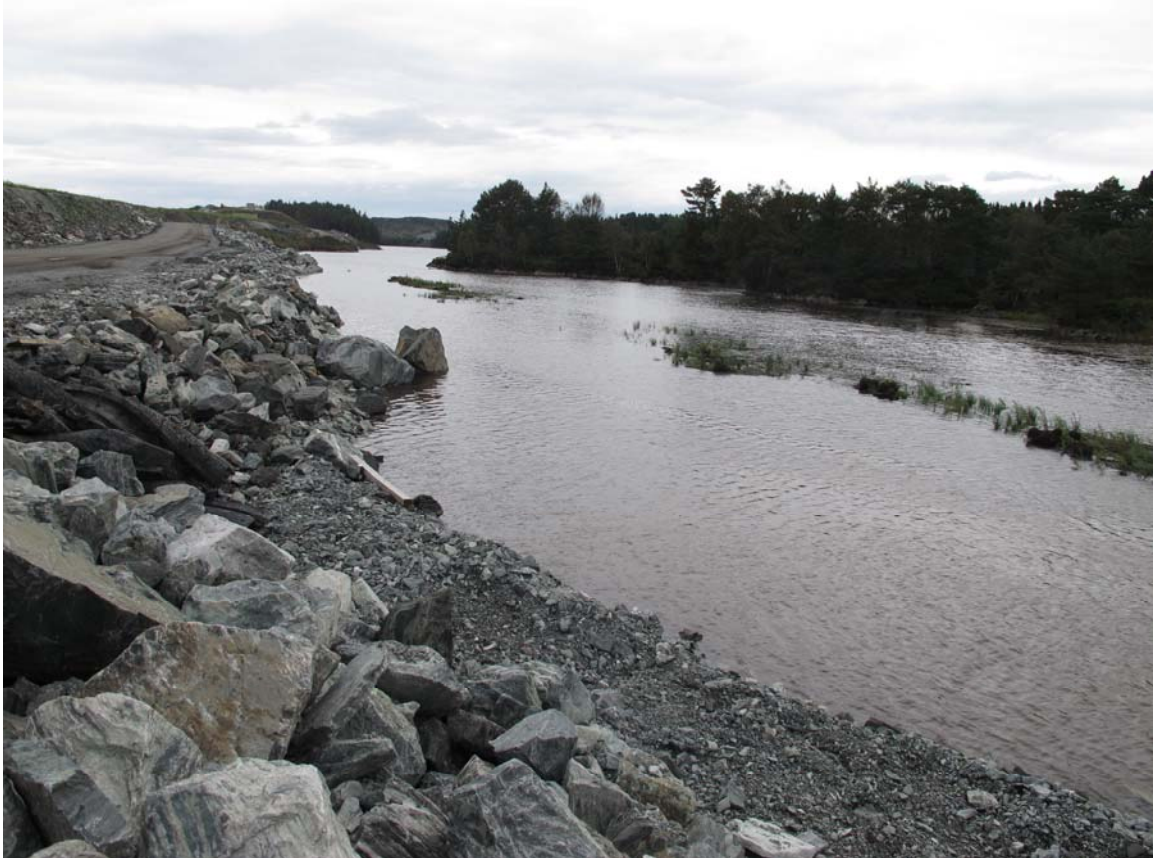
Figur 19. I Langavatnet foregår det utfylling på vestsiden. Foto: Oddmund Wold.
