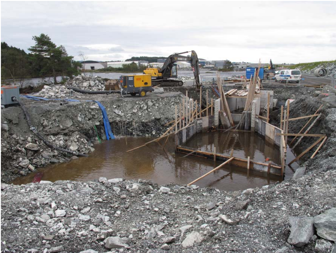
Figur 20. Bygging av kunstig elveløp med fisketrapper for å opprettholde tilgjengelighet for ål og gytemuligheter for sjørret. Foto: Oddmund Wold 2011.
