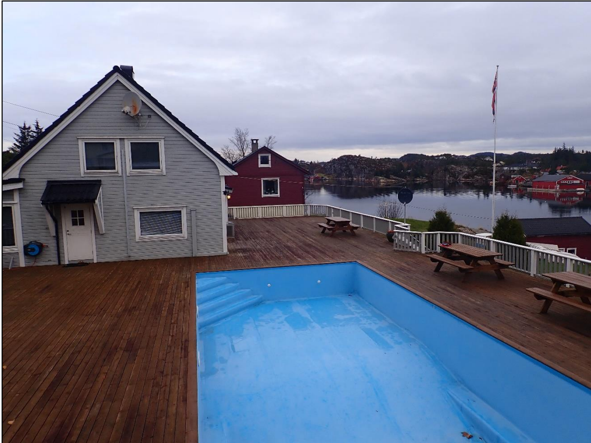
Figur 3-2: Terrasse mot sørøst tilhørende enebolig med gnr./bnr. 19/39
