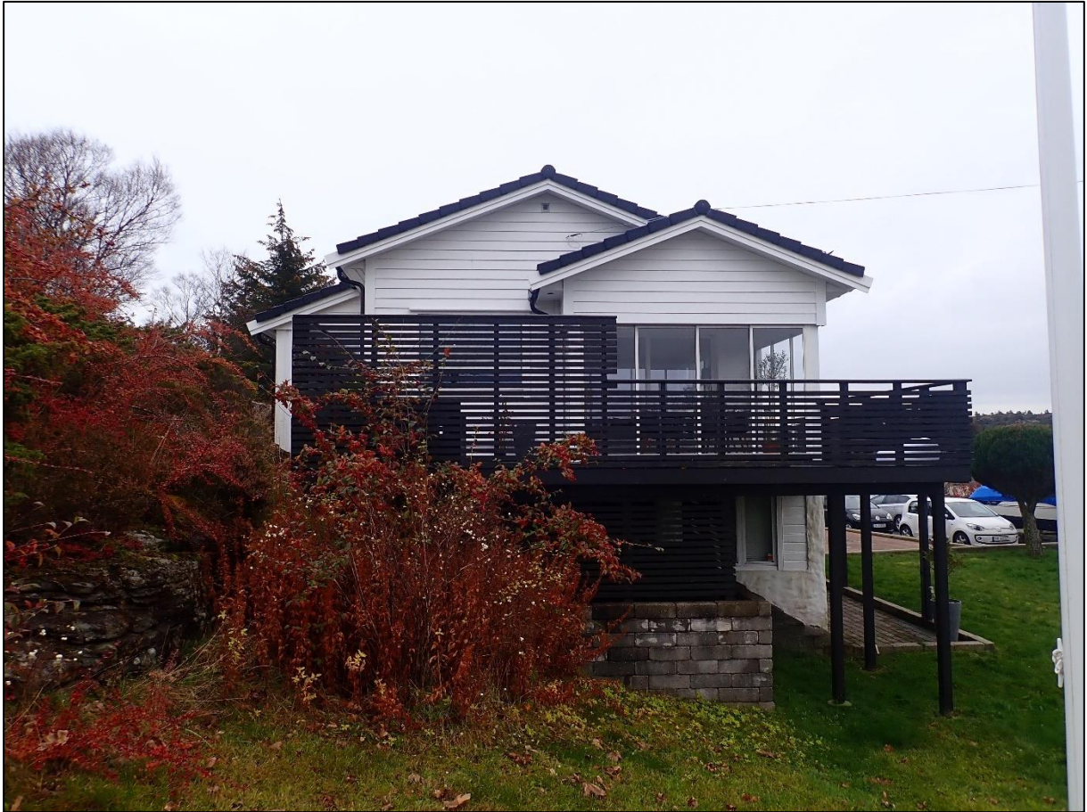
Figur 3-2: Veranda mot vest tilhørende enebolig med gnr./bnr. 19/276.
