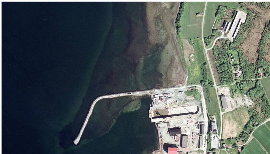
Figur 10 - Historisk luftfoto som viser marbakkens posisjon
