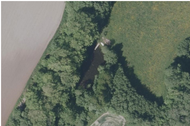
Figur 14: Dam på eiendommen Reitan gnr./bnr. 2/1.
